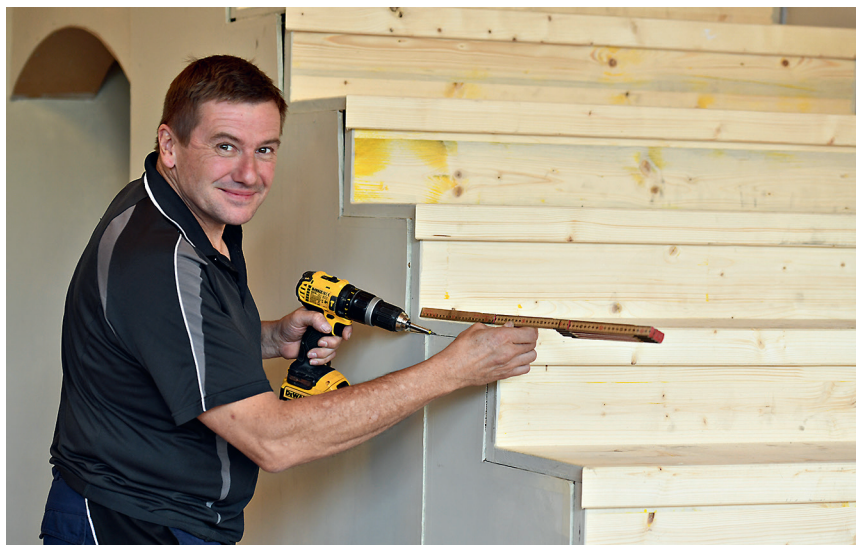
Bühnenbauer Markus Röthlin sorgt dafür, dass die Treppenstufen waagrecht ausfallen.
